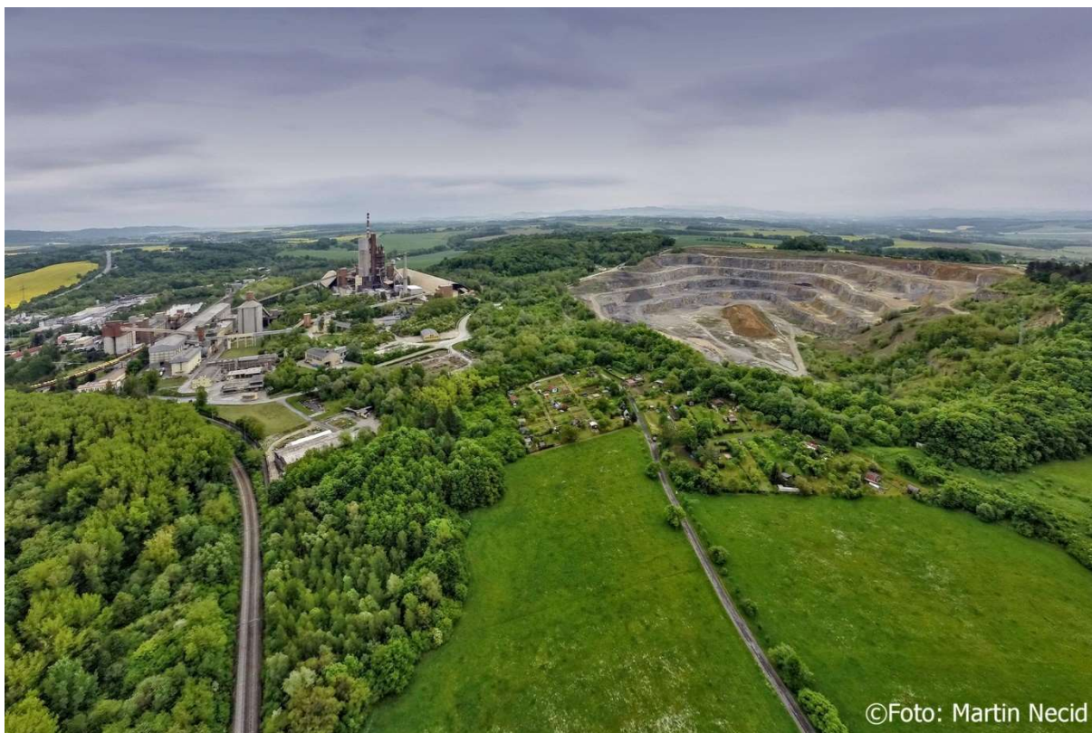
Obr. 8 Letecký pohled na vápencový lom a areál hranické cementárny (zdroj: Martin Necid)
