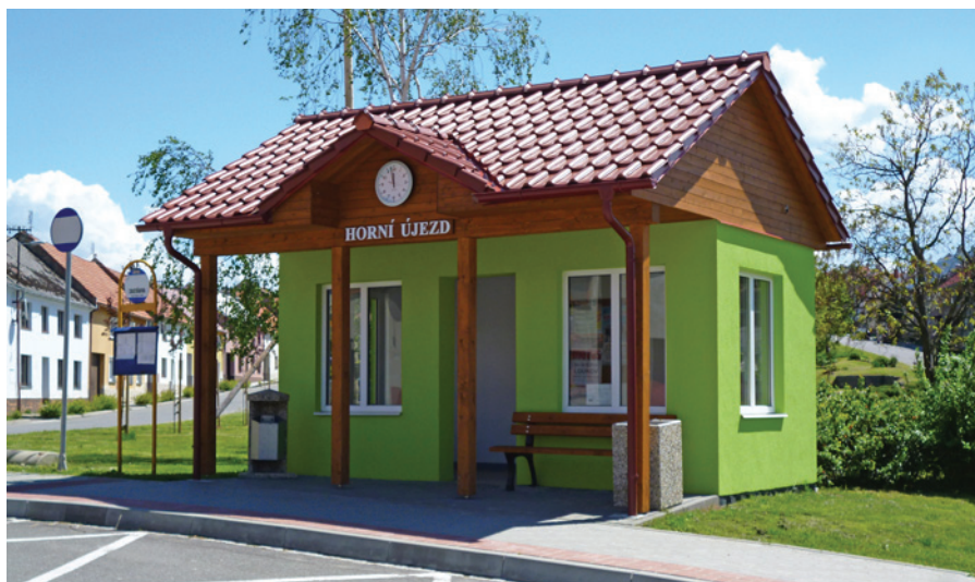
Náves v Horním Újezdě kráší nová autobusová zastávka, obnovena byla také okolní zeleň
