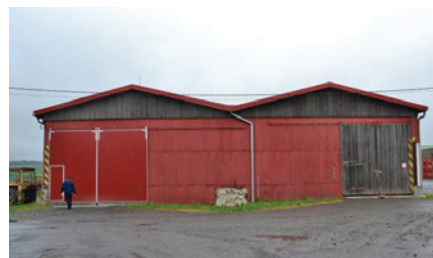
Zrekonstruovaná hala v ZD Partutovice
