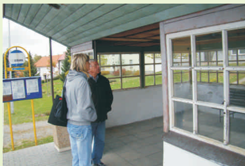
Kontrola před zahájením realizace proběhla také v Opatovicích
